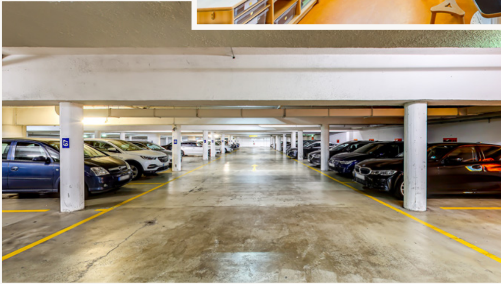
HAUSEIGENE TIEFGARAGE MIT ERGÄNZENDEM SICHERHEITSDIENST
